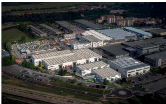
SITE DE FABRICATION
